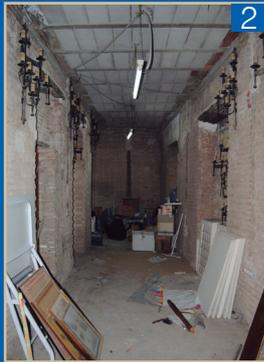
1, 2, 3 y 4.- Estado anterior de las estancias: suelo de hormigón, paredes sin enfoscar, falta general de enlucimiento y vigas apollilladas de madera que fueron sustituidas por otras de hormigón.
